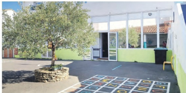
Après la cour principale, il reste de nombreux travaux de rénovation à effectuer au sein de l'établissement. © S.G.
